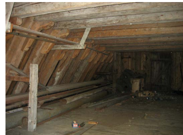
Figur 33. Krutkappellets interiör, mot norr. Byggnadens stomme är mycke välbevarad. Foto: Göteborgs Energi
